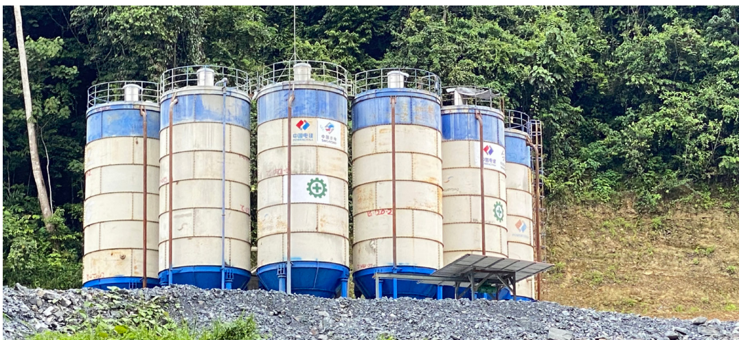
Gambar 12. Bangunan Berlogo PT Sinohydro di Lokasi Proyek Bendungan.
