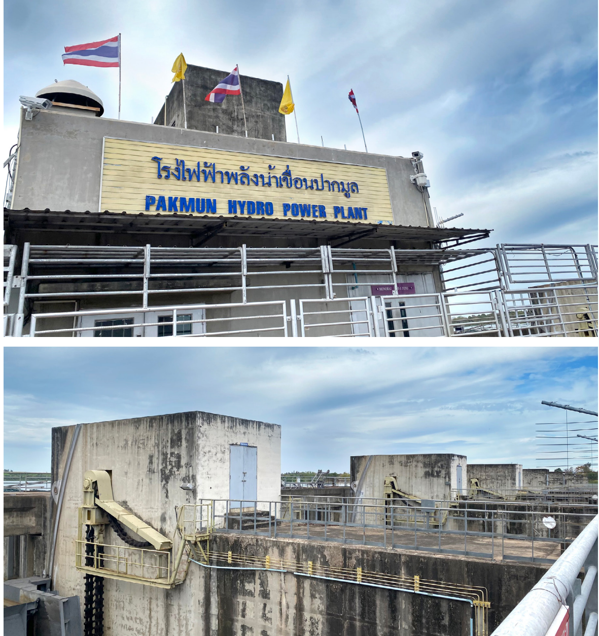
Gambar 15. Kontruksi Bendungan Pak Mun, Thailand.
