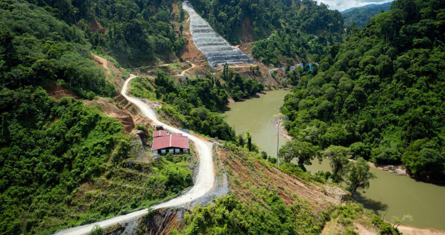
Gambar 45. Buka an Jalan untuk Mobilisasi Material dan Pembangunan Fasilitas PT KHN.
